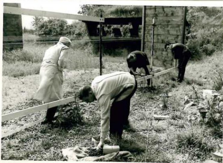
Befestigen der Querlatten
