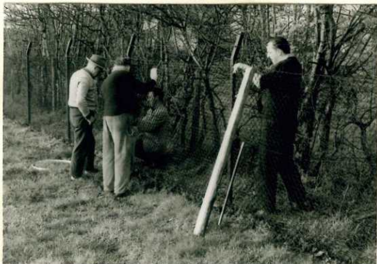
Wieder Arbeiten auf dem Platz.
